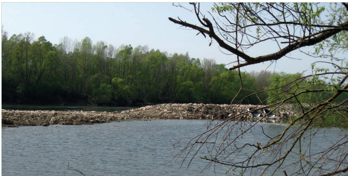
A Drávatamási felső mellékág köművének lecsökkentett koronaszintje
