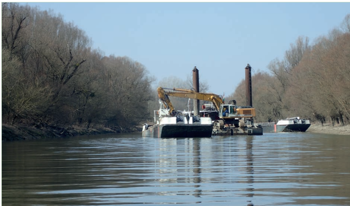
Kotrógép rakodja a bárkát a Rezéti-Dunán
