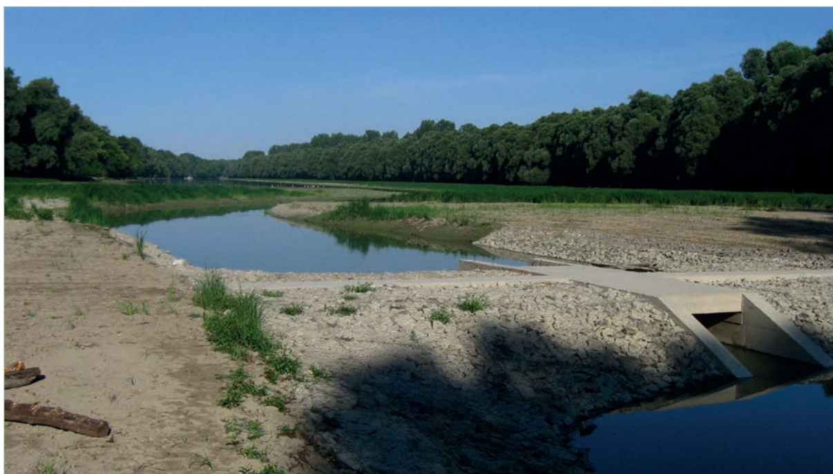
A Grébec-Duna vízvisszatartó műtárgya kisvízes időszakban
