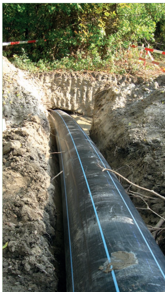
Új vízvezeték behúzása a mohácsi Szabadság-zátonyon
